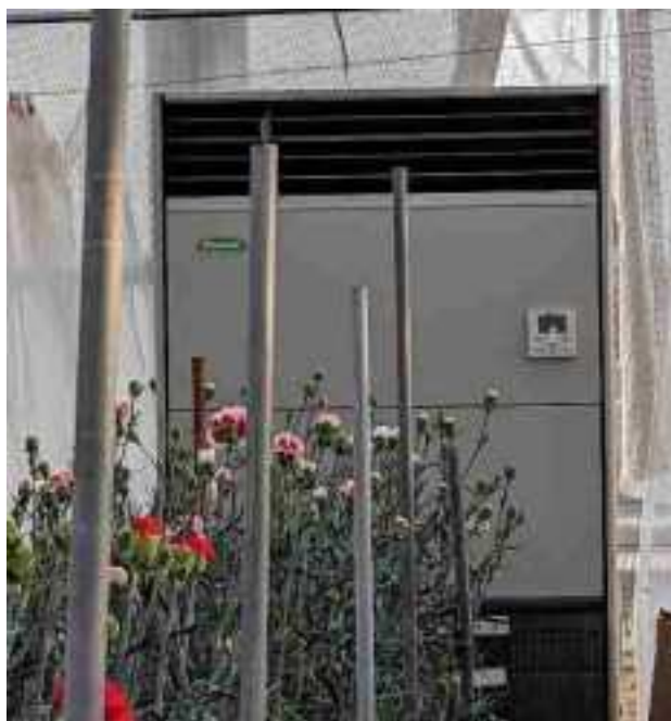
ヒートポンプでのカーネーション栽培
